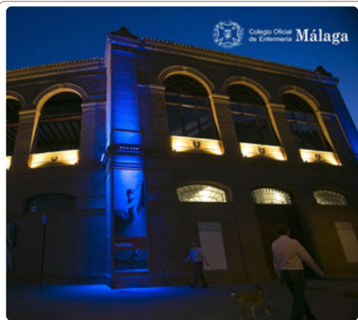
Plaza de Toros de La Malagüeta (Málaga)
