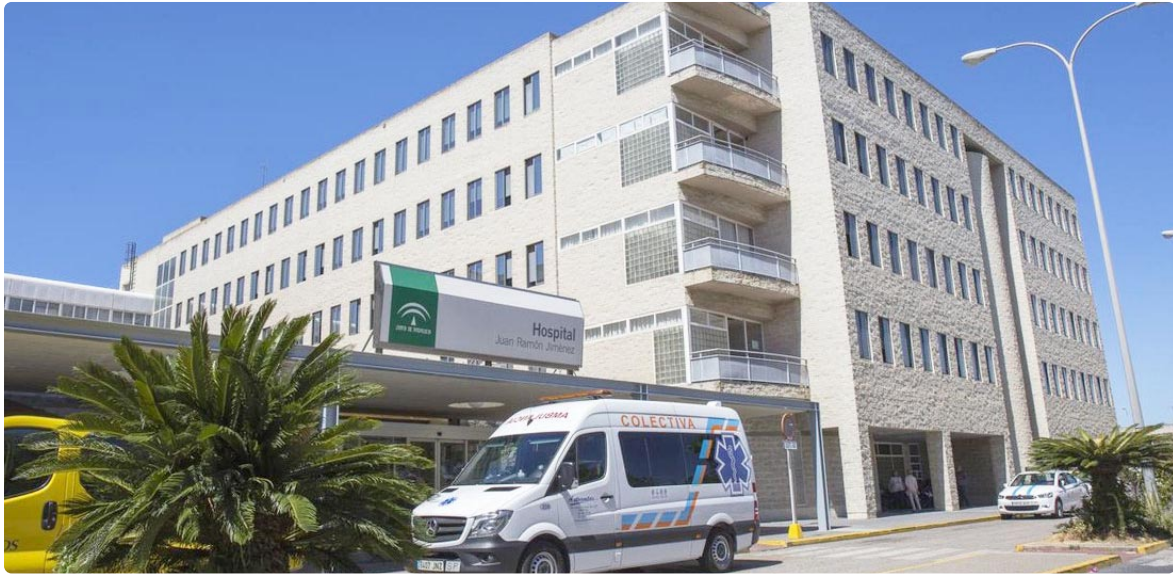
Instalaciones del Hospital onubense Juan Ramón Jiménez
